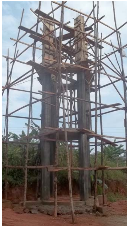
5. fin armature des 4 poteaux encore coffrés
