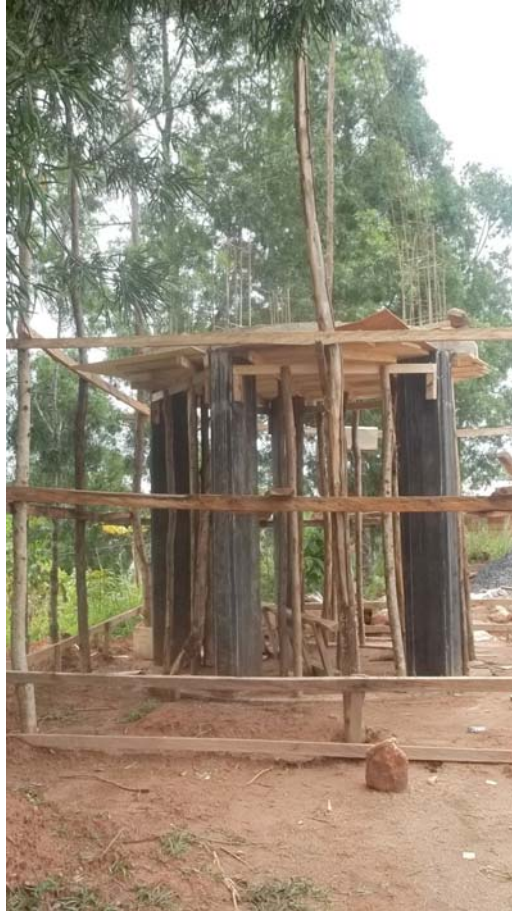
9. armature de 5 poteaux
