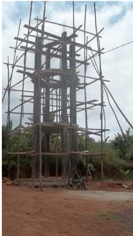
6. fin armature des 4 poteaux décoffrés de 9 mètres de haut
