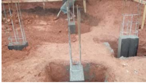
3. armature de 4 poteaux
