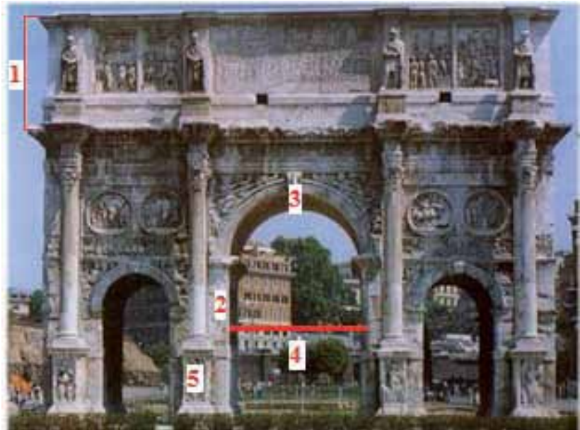
25. Arco di Costantino, 315-316 d.C., Roma 1. Attico 2. Pilastr 3. Arco 4. Fornice (passaggio) 5. Plinto
